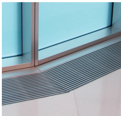
Versteksnede in lineair rooster, uitvoering geanodiseerd aluminium, hoekvorm
