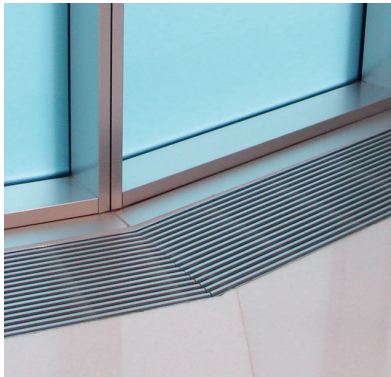
Coupe d'onglet dans la grille linéaire, exécution aluminium coudée anodisée
