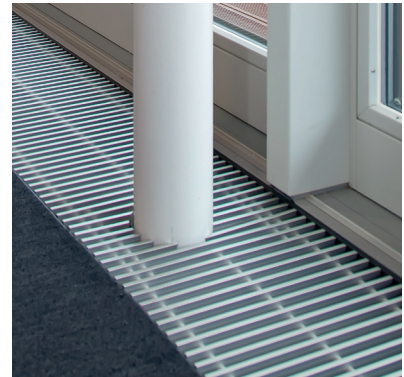
Coupe de colonne dans l'exécution grille à rouleaux
