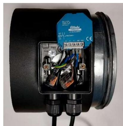
Etape 5) Remettez le tout joliment dans la boîte de jonction, fermez la boîte de jonction sur l'élément de préchauffage et l'installation est terminée.
