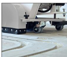
Les tubes de chauffage par le sol sont déposés dans des rainures pratiquées dans la chape de ciment ou à l'anhydrite. Dans ce cas, vous ne devez pas tenir compte de la hauteur de structure de plancher supplémentaire. Les rainures sont réalisées absolument sans poussière par notre propre service de rainurage. Si vous désirez de plus amples informations sur notre service de rainurage, contactez votre représentant Vasco.
